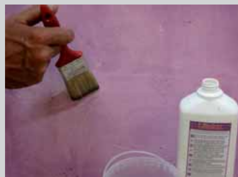
Использование LITOLUX в качестве финишного защитного покрытия поверхности из STARLIKE DECOR .
