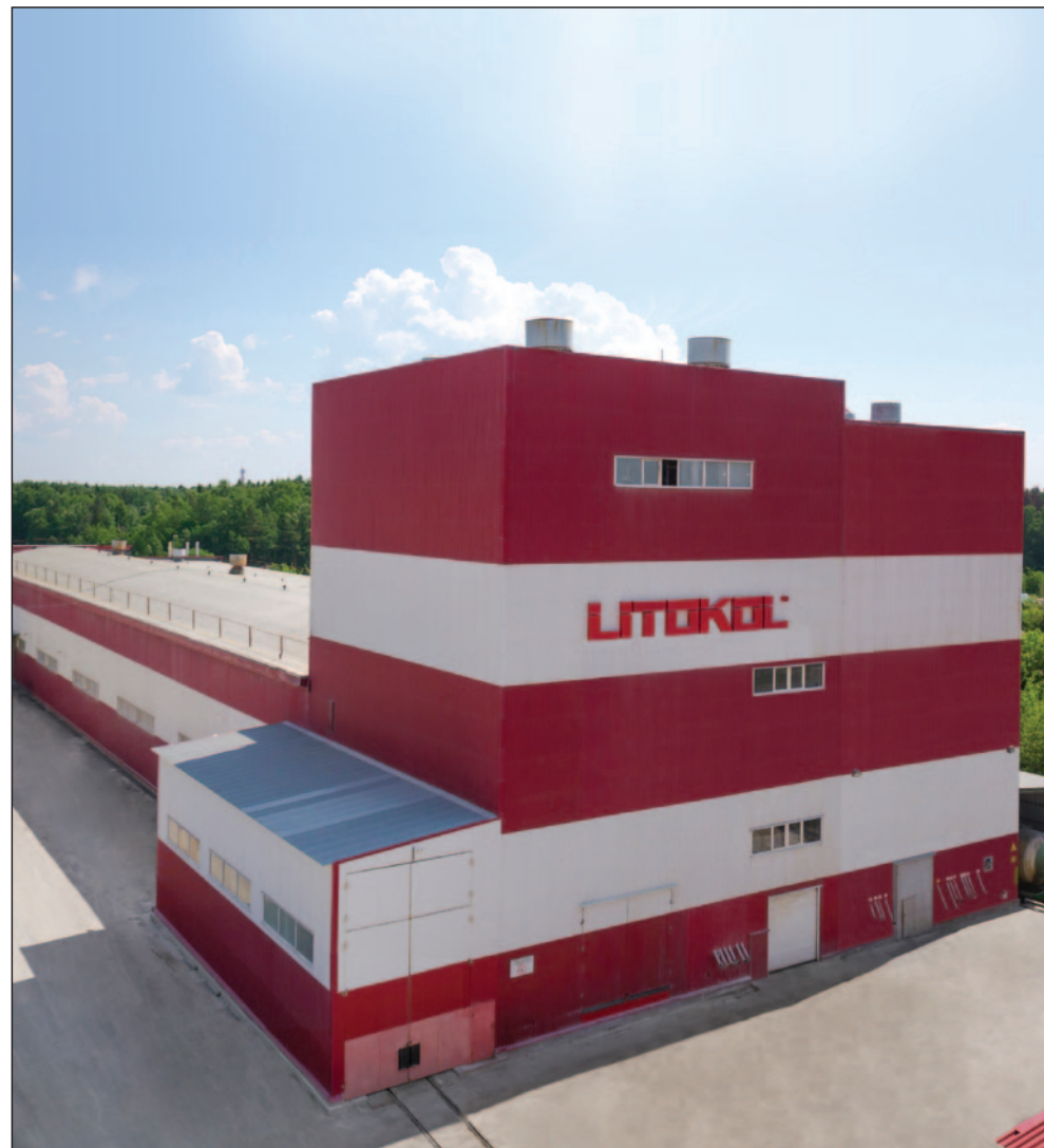
Ногинский Комбинат Строительных Смесей
