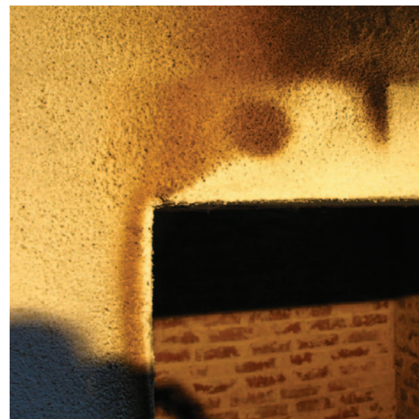
Стенд по завершении эксперимента: верхний откос имитации оконного проема после получасового воздействия огня. Итог: накрывные слои СФТК LITOTHERM сохранили целостность.
